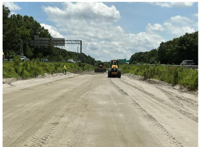
Median Fill Placement
