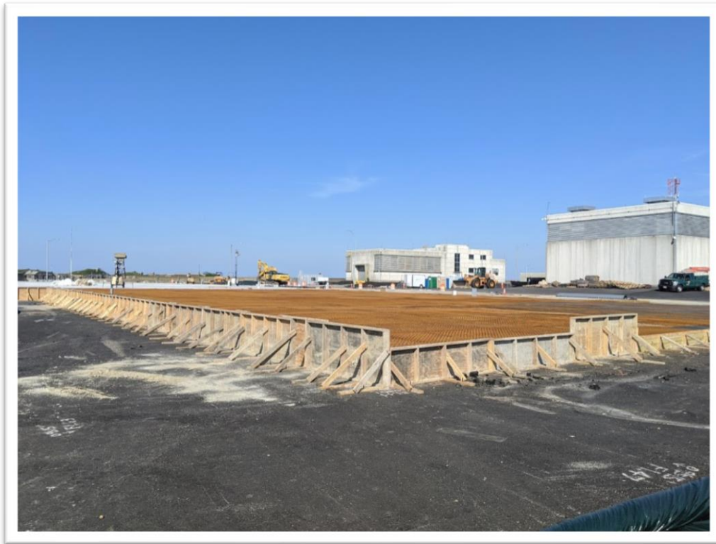
Temporary Slab Ready for Concrete Pour
